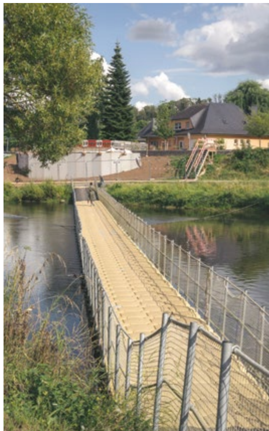
Die provisorische Wasserbrücke bei der Ficellesbréck . Le pont flottant provisoire près de la Ficellesbréck .
