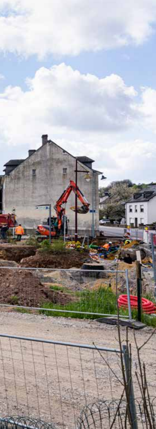
Blick auf die Baustelle in Erpeldingen-Sauer. Vues du chantier d'Erpeldange-sur-Sûre.
